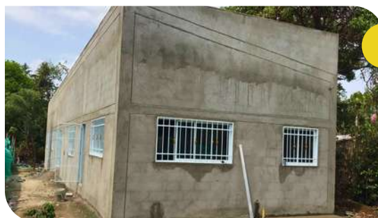
Construcción de Comedor Escolar.
