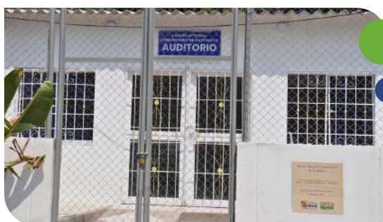
Construcción de Centro Integral Comunitario y Mejoramiento de Acueducto.
